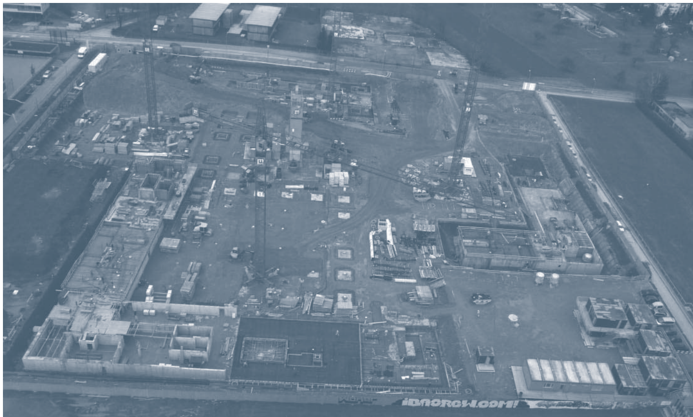
Flugaufnahme Baustelle, März 2009.
